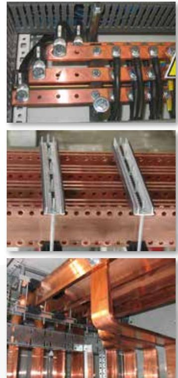
On utilise actuellement deux métaux comme conducteurs dans les tableaux électriques: le cuivre et l'aluminium. En particulier, si on veut déterminer une distribution de puissance à l'intérieur d'un tableau électrique, on utilise principalement des barres tréfilées, réalisées dans l'un des deux métaux ci-dessus.
