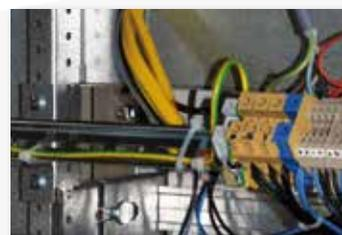
Rails DIN en acier et aluminium standardisés conformément aux normes européennes, ce qui permet le montage d'appareils électriques modulaires et autres à l'intérieur de tableaux électriques.
