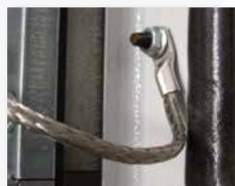
La tresse de cuivre sert de conducteur extra flexible pour toutes les exigences de connexion électrique, y compris de puissance, de terre et équipotentielle.
